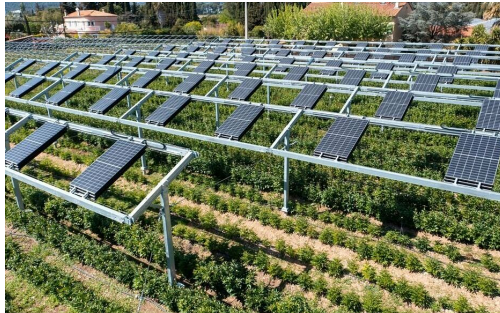
Avec la start-up Ombrea, Total Energies a développé des panneaux solaires rétractables qui peuvent couvrir les surfaces cultivées et les protéger des intempéries. DR
